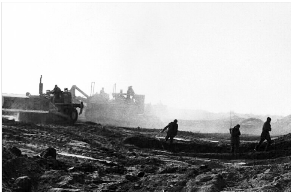
فعالیت نیروهای مهندسی (منطقه عملیاتی رمضان)
