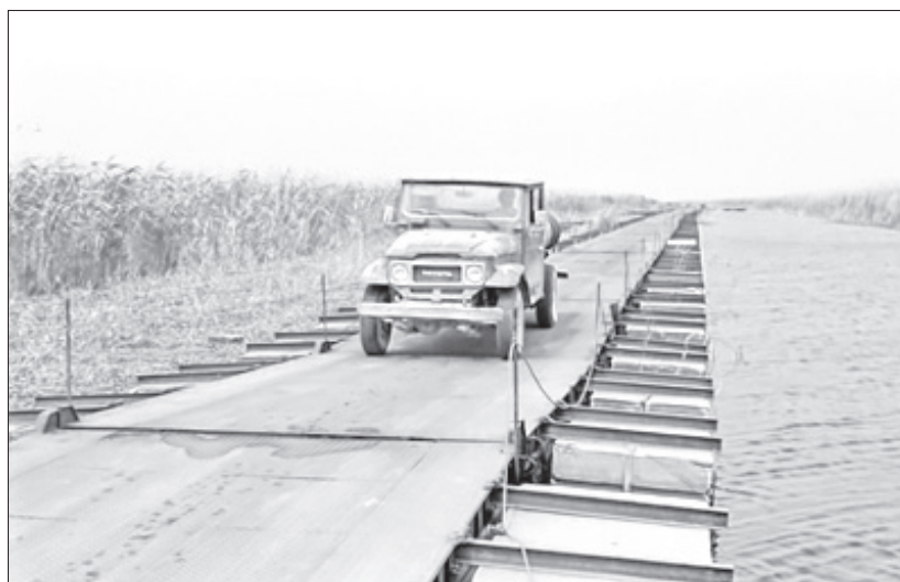
مزیت پل خیبری که مابین جزیره شمالی مجنون و ساحل هورالهویزه نصب شد این بود که با بالا و پایین رفتن آب هور، پل هم بالا و پایین می‌رفت.
