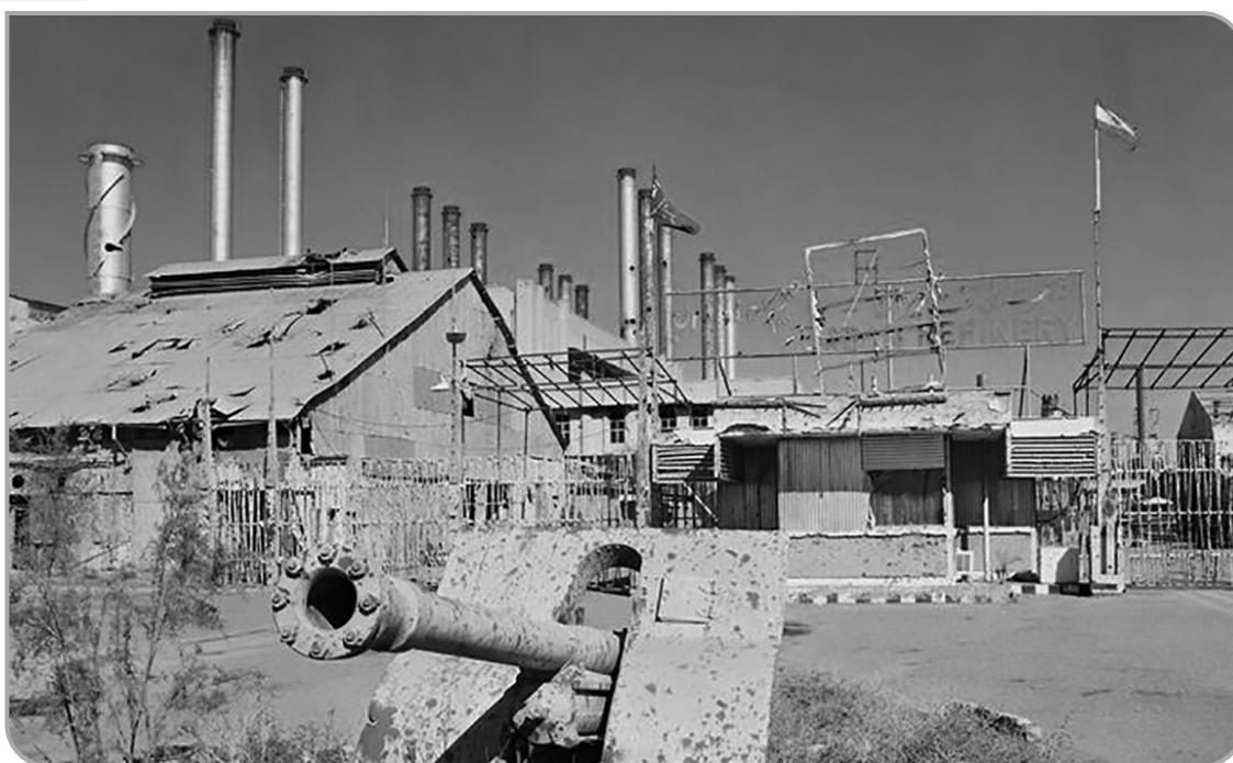
نمای دروازه اصلی پالایشگاه آبادان پس از تخریب ناشی از بمباران نیروهای عراقی - سال ۱۳۶۱
