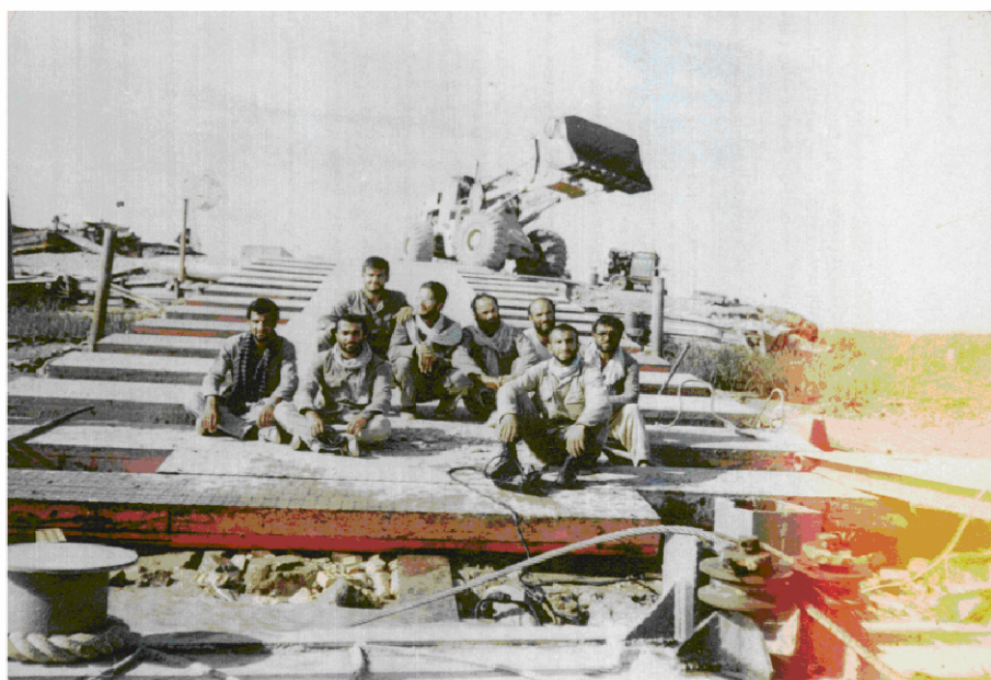
اکیب مهندسی مجری اسکله های فلزی بل متحرک فاو - اروند رود بر روی یکی از اسکله های در دست اجرا سال ۱۳۶۵
