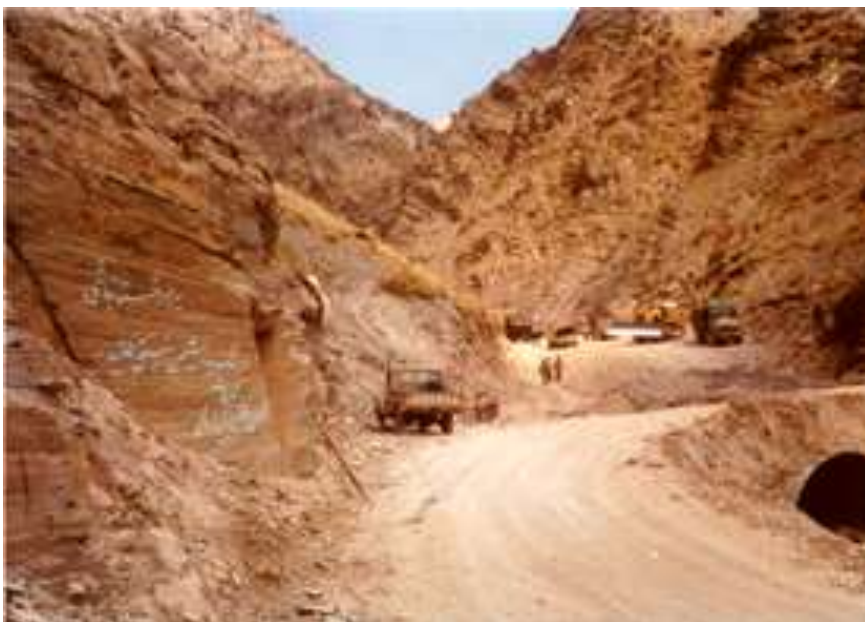
آماده‌سازی منطقه عملیاتی حاج‌عمران
